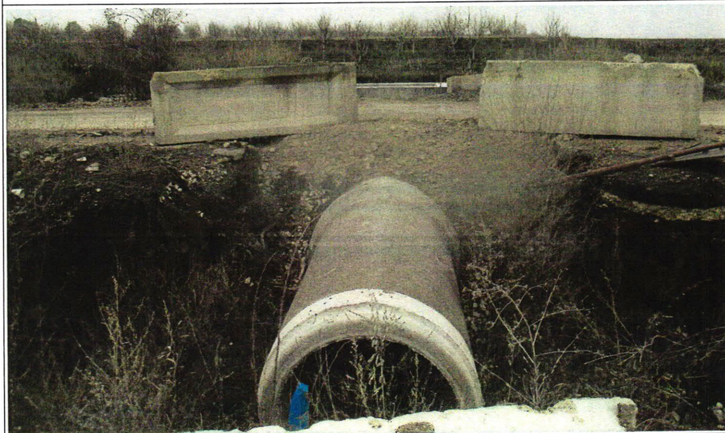
Vedere capăt aval
