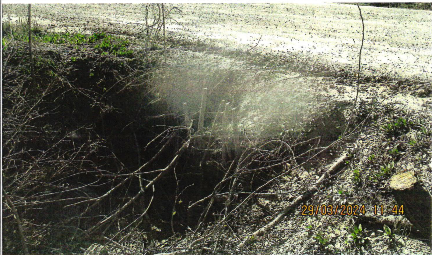
Vedere capăt aval
