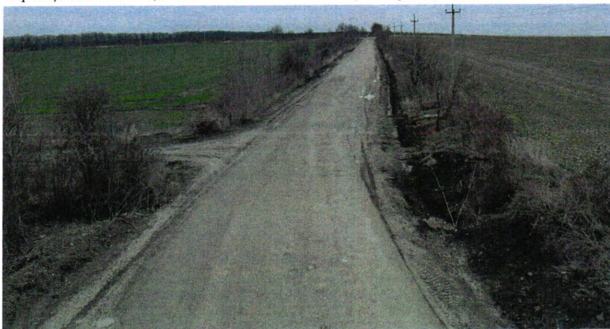
Figura 18. Drumul L103, Podețul Pc 3+45. Starea/Etapa executată la faza de execuție
