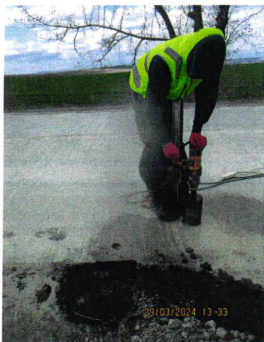
Figura 8. Prelevare de carote (km 2+350)
