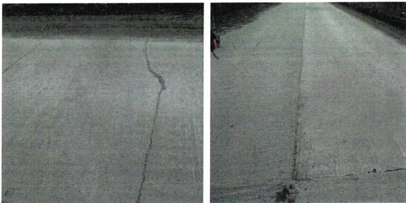
Figura 3. Decolmatarea rosturilor la km 2+650, km 2+750.
