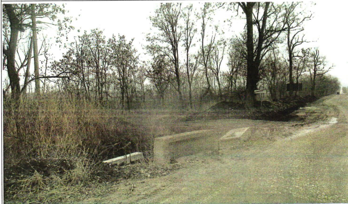
Vedere capăt aval
